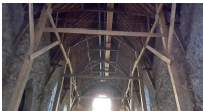
*Les jambes de force de la charpente de la nef rajoutée en 2008 sont ancrées dans la maçonnerie et engendrent une altération de la matière. Celles-ci sont reliées, de part et d'autre de la nef, par des tirants métalliques non tendus.*
