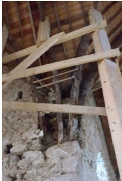
*Un défaut d'assemblage et de liaison de la charpente du transept sur les murs périphériques (celles-ci ne sont plus solidaires l'un de l'autre)*
