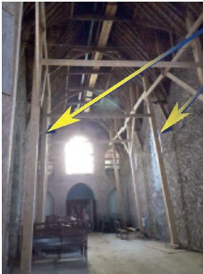
*Les charges verticales de la charpente sur les murs maçonnés sont reprises par des confortements en périphérie du bâtiment correspondant aux poteaux. Ces confortements correspondent aux poteaux sous chaque ferme*
