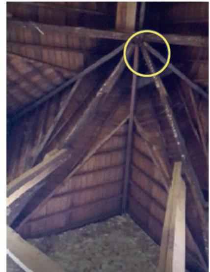
*La désolidarisation de l'assemblage de la charpente du chœur à la charpente du transept. Cette pathologie engendre une poussée des efforts horizontaux dans le pignon vers l'extérieur, expliquant la fissure de 2013.*
