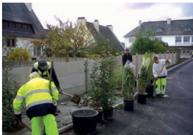
Travaux d'aménagement paysager à l'école
