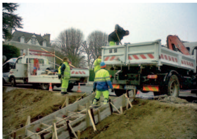
Travaux de création d'un escalier aux abords de la mairie
