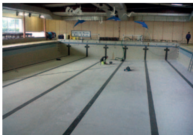
Travaux de réfection à la piscine municipale
