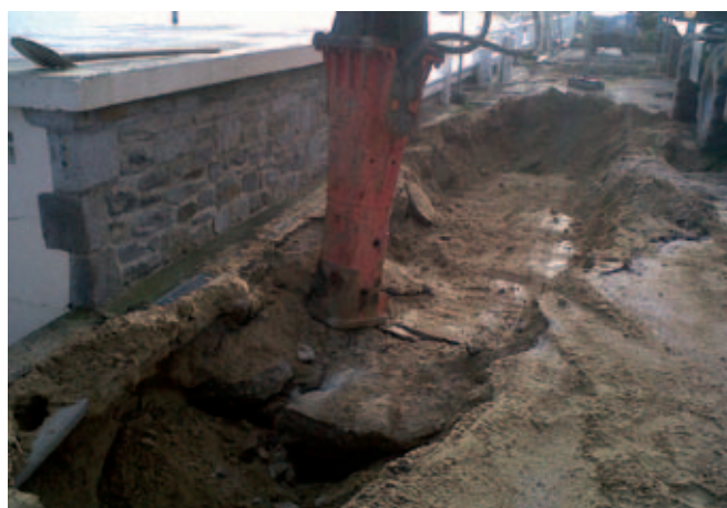
Travaux de branchement des futures toilettes publiques
