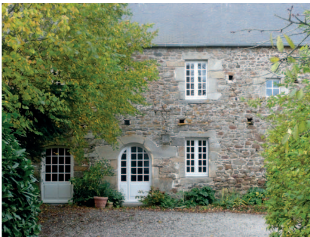
La chapelle a été transformée en maison d'habitation au début du XIX e siècle ; on ne la remarque pas dans le hameau de Saint-Jaguel.
