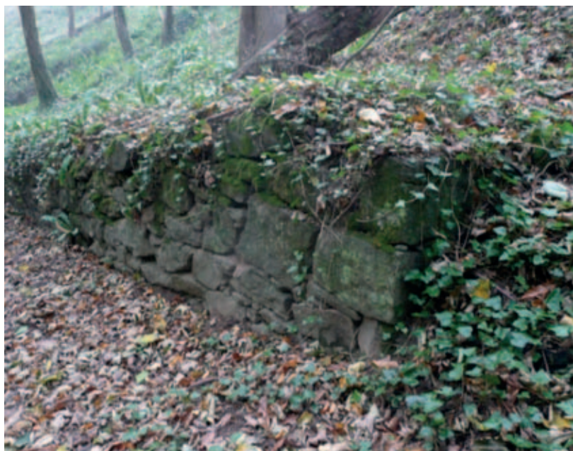
Actuellement, on distingue encore des murs de soutènement sur le terrain en pente bordant la mer qui avait été aménagé pour le passage des charrettes. L'utilisation de cette voie pendant des siècles a laissé de profondes ornières dans le roc dans les parties difficiles du trajet
