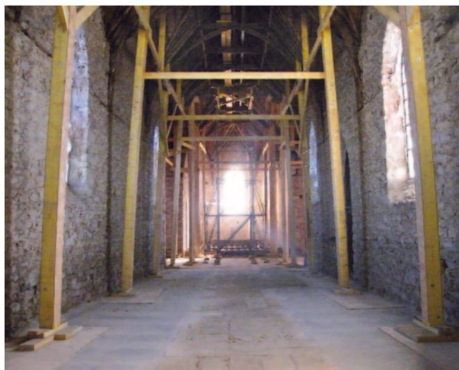
La 1<sup>ère</sup> intervention a pour objectif la mise à nu des structures mur et charpentes.
