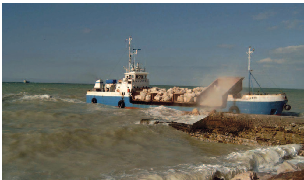
Les travaux de dragage, déroctage, terrassements du fond de bassin et des têtes rocheuses dans le chenal.
